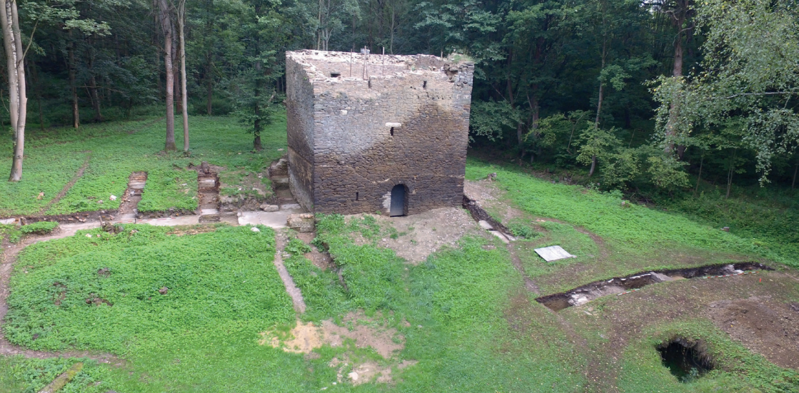
Pohled na archeologické průzkumy a rekonstrukční práce v horních partiích tvrze Pomezná, rok 2017. Foto Jan Kuběnka.
